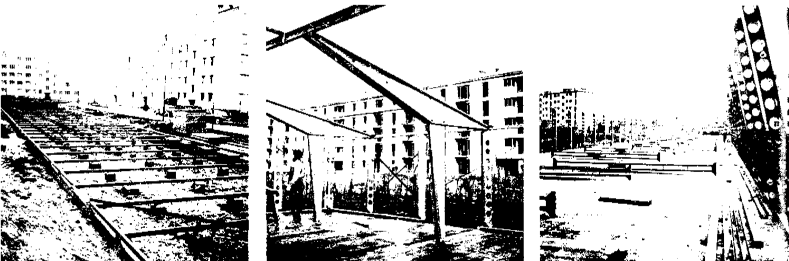
Fig. 5 à 7. Trois vues prises au cours du montage.
